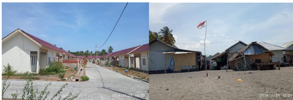
Gambar 3. Kondisi Rumah di Kabupaten Lombok Utara
