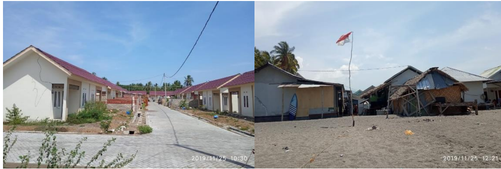
Gambar 1. Kondisi Rumah di Kabupaten Lombok Utara
