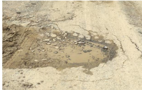
Gambar 2. Kerusakan Lubang
